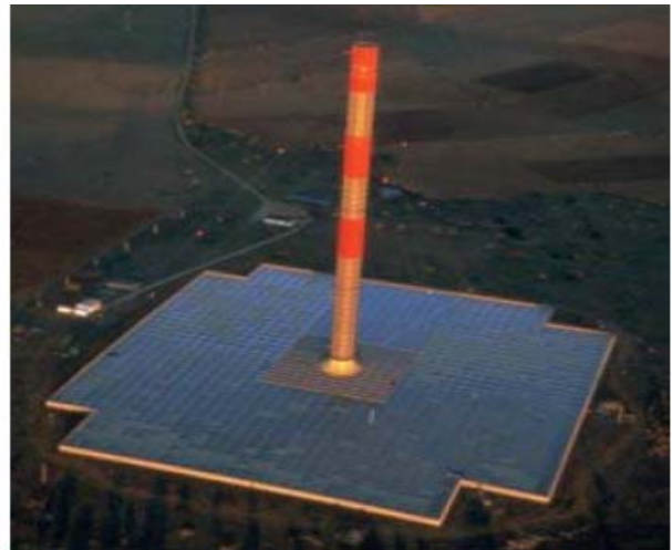
7. Солнечная тепловая башня с турбиной восходящего потока. Экспериментальный проект в Манзанарес (Испания).
