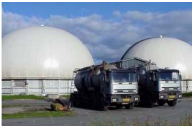
9. Хранение биогаза. © 2004 www.blaabjergbiogas.dk
