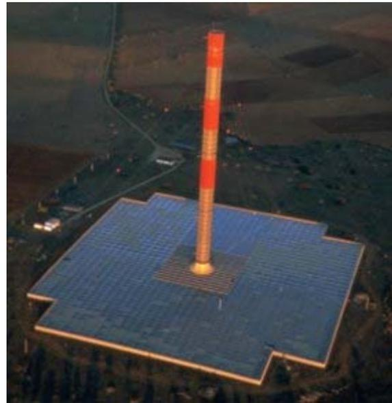
7. Solarthermischer Turm mit Aufwind-Turbine. Pilotprojekt in Manzanares (Spanien).
