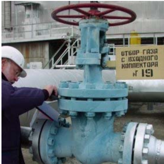
9. Untersuchung von Ventilflanschen © LA
