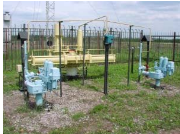
3. Soupape du pipeline, qui est enterré - près de Kursk © LA Cliquer sur l'image pour l'agrandir! (180 K)
