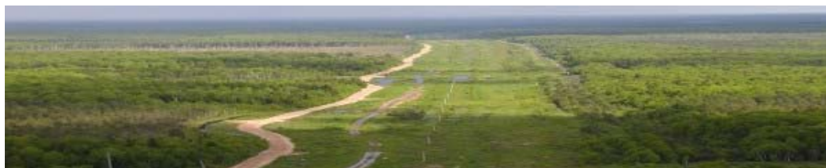
1. Vue d'hélicoptère du trajet d'un pipeline. Le pipeline est enterré à 1.5 m sous la surface © LA
