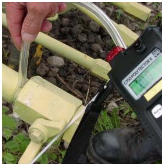
10. Contrôle avec un détecteur de méthane
