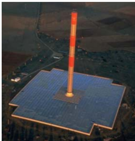
7. Tour solaire thermique avec une turbine à vent ascendant. Projet pilote à Manzanar (Espagne).
