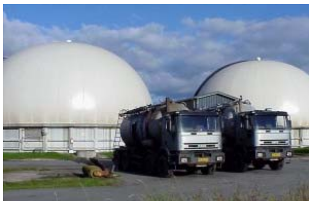
9. Entreposage de biogaz © 2004 www.blaabjergbiogas.dk
