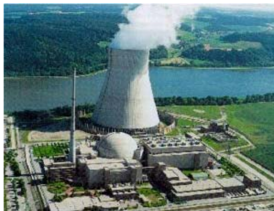
1. Centrale nucléaire © Technische Universität Braunschweig
