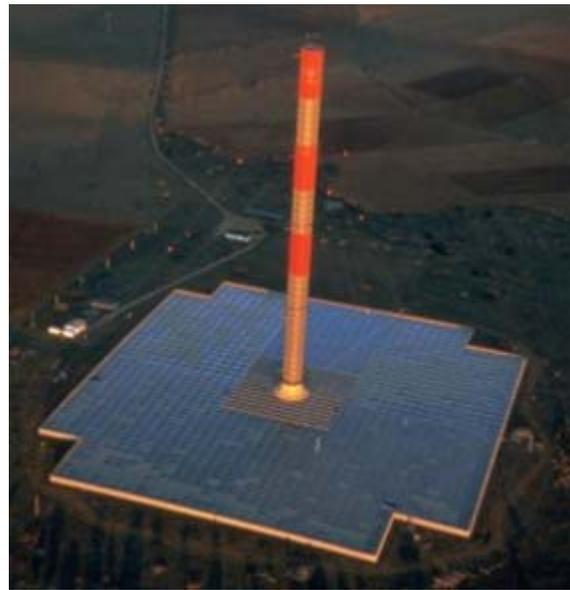
7. Torre termica solare con turbina eolica. Progetto pilota a Manzanares (Spagna).
