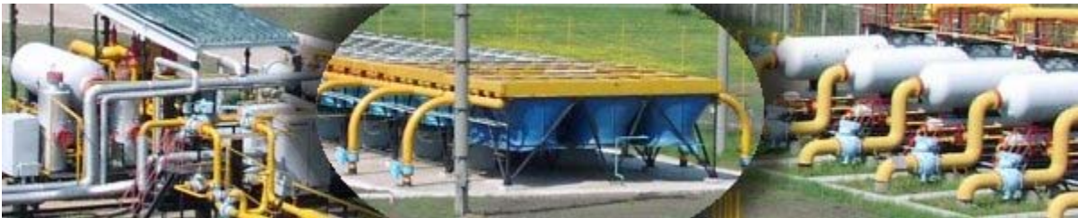
6. Refrigeranti, essiccatori e apparati che convogliano il gas combustibile presso la stazione di compressione di Kursk. © LA
