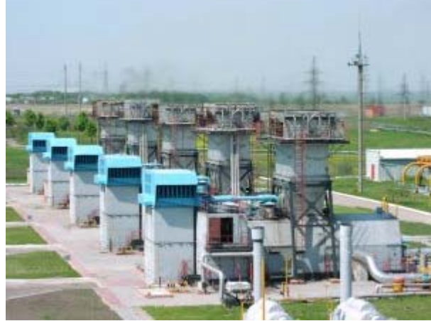
5. Compressori e turbine presso la stazione di Kursk © LA
