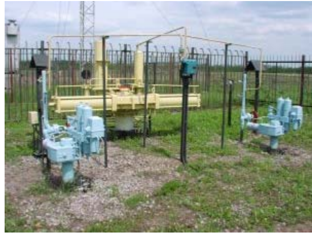
3. Snodo sotterraneo di valvole in un gasdotto vicino a Kursk © LA
