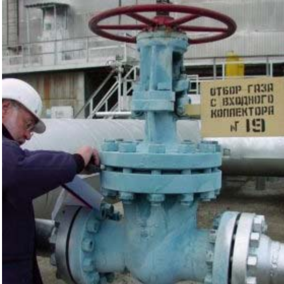
9. Controllo delle flange di una valvola © LA
